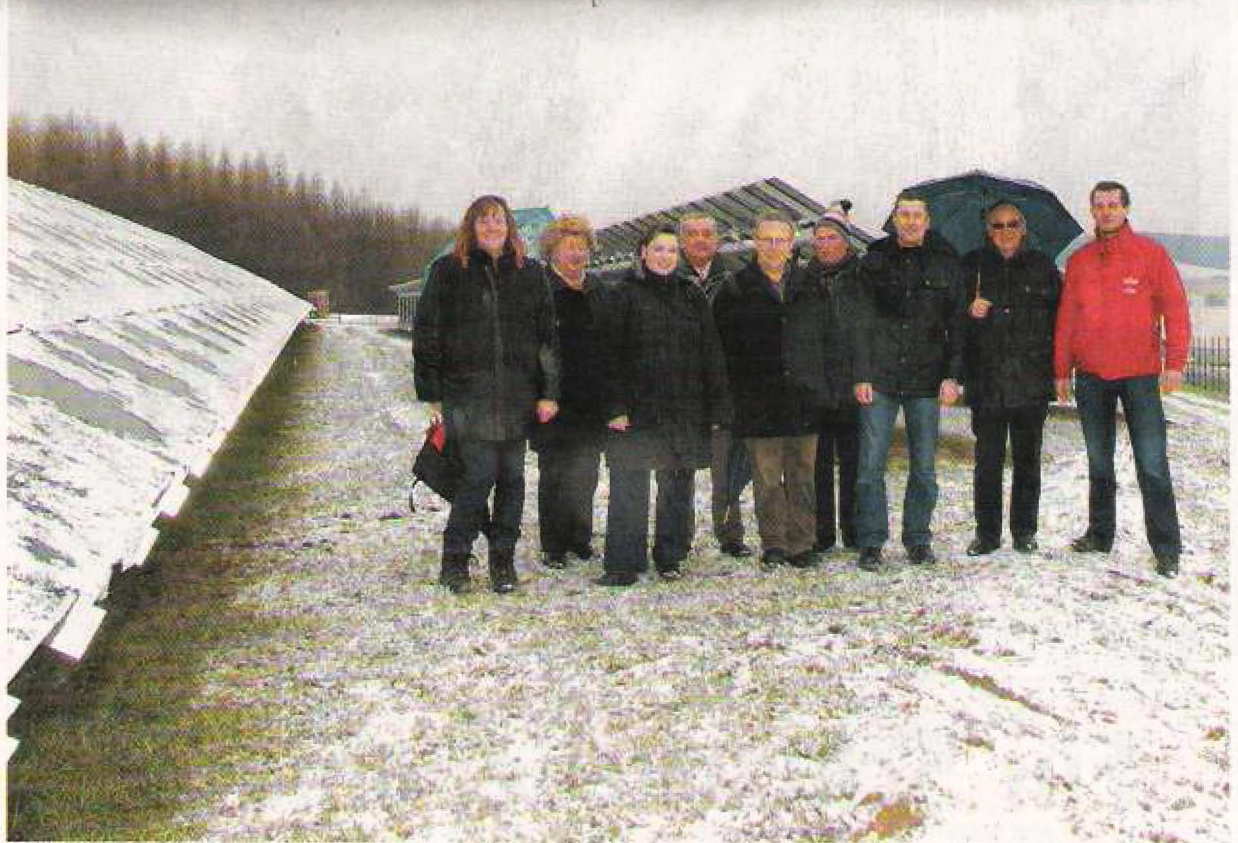
Zwei Tage vor Jahresende wurde der Villenbacher Solarpark ans Netz angeschlossen. Nun wird von hier aus Strom geliefert. Auf dem Bild von links: Ute Refle, Resi Kröner, Felicitas Refle, Karl Mengele, Franz Refle, Alois Kröner, Markus Kröner, Bürgermeister Otmar Ohnheiser, Florian Bichler (Energiebauern GmbH). Foto: Bunk
