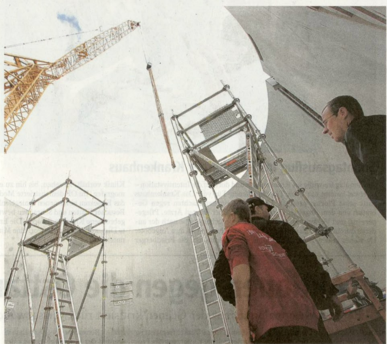
Zwischen Sielenbach und Laimering konnten sich Interessierte gestern ein Bild von der Baustelle machen, an der die umstrittenen Windräder errichtet werden sollen. Hier Halbschalenelemente, die später zum unteren Turm gehören. Fotos: Sophie Schmid
