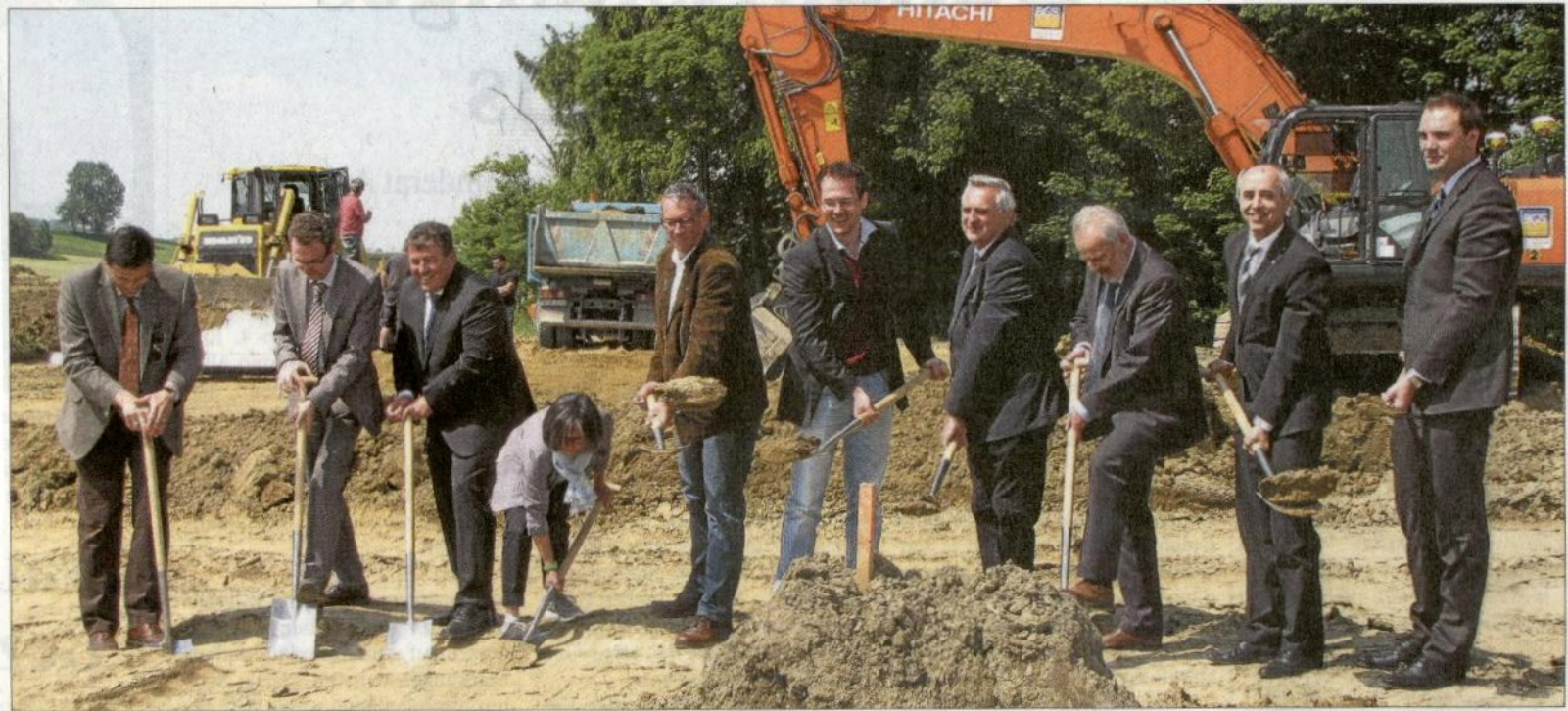
Zum Spatenstich waren unter anderem Grundstückseigentümer, beteiligte Baufirmen, Vertreter der Banken sowie die Bürgermeister der drei Kommunen anwesend, auf deren Fluren der Windpark errichtet wird. Im Bild von links: Wolf-Dietrich Graf von Hundt, Administrator der Fuggerschen Stiftungen, Roland Birkel (Sparkasse Dachau), Günter Hahn (VR-Bank Adelzhausen-Sielenbach), Anne Glas (Zweite Bürgermeisterin von Dasing), Jörg Merk (BGS Tiefbau), Energiebauern-Geschäftsführer Florian Bichler, die beiden Bürgermeister Martin Echter und Klaus Habermann sowie Peter Burnhauser (Raiffeisenbank Kissing-Mering) und Michael Brechtelsbauer (DZ Bank Frankfurt). Foto: Robert Edler
