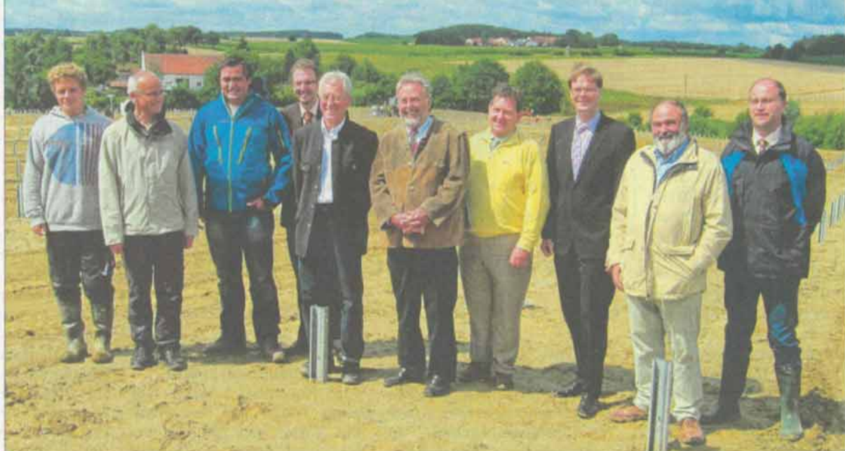
Zum ersten Spatenstich haben sich die Bauherren, die Vertreter der Fachbehörden und der Sparkasse am künftigen Solarpark eingefunden. Fotos: osj
